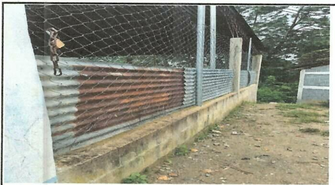
Foto 3: Se mejorará el muro perimetral con block
